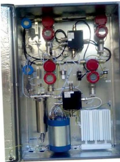
Комплект газоаналитического оборудования для мониторинга выхлопных газов ГПА на основе датчиков ДАХ-М-09-СО-500/-09-NO-200/-09-О<sub>2</sub>-21
