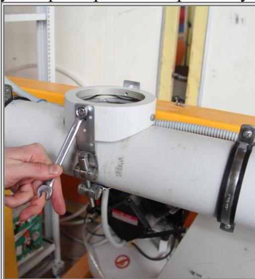
6.4.8. Затянуть ключом на 12 стяжной винт. Монтажное основание не должно прокручиваться или смещаться. Не должно быть зазоров в месте примыкания монтажного основания к трубе.
