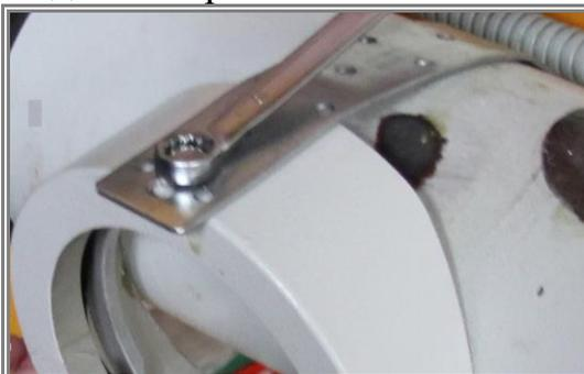
6.4.7. Установить на трубу и зафиксировать второй хомут на 2 болта.
