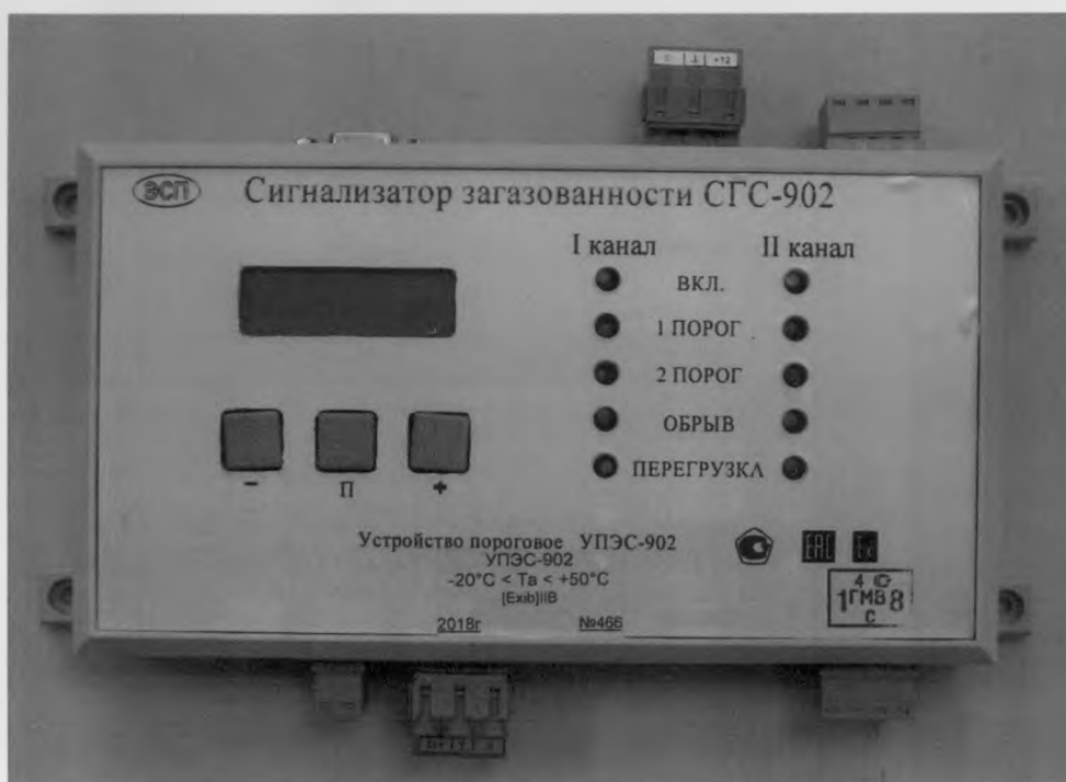
а) устройство пороговое двухканальное УПЭС-902
