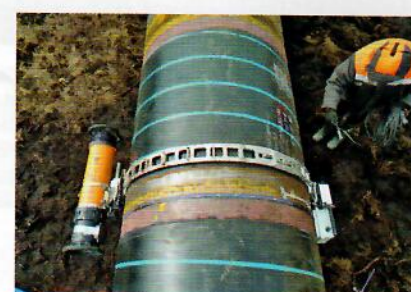
Рис. 3. Комплекс «ТРАНСКАН». Контроль по схеме «Фронтально» (через две стенки) на строительстве МГ «Сила Сибири», этап 2.7, участок 1636–1817,9 км, май 2018 г. Труба 1420 × 21,7 мм, время монтажа/демонтажа комплекса 5–7 мин, время контроля сварного соединения 21 мин
