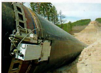
Рис. 2. Комплекс цифровой радиографии «ТРАНСКАН». Контроль по схеме «Панорамно» на строительстве МГ «Сила Сибири», этап 2.7, участок 1636–1817,9 км, май 2018 г. Труба 1420 × 21,7–25,8 мм, время монтажа/демонтажа комплекса 3–5 мин, время контроля 200–220 с
