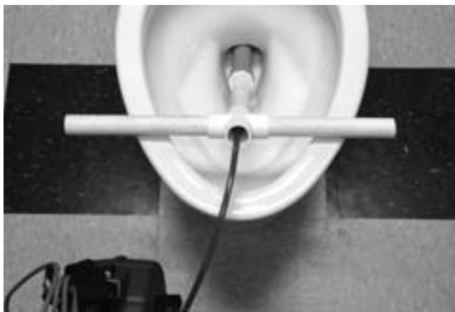
Рис. 25. Использование гибкой направляющей трубы
