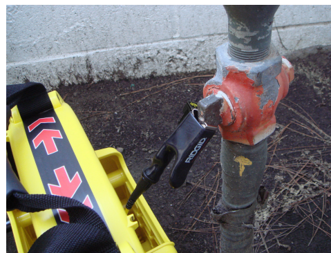
Рисунок 7 – Подводящий провод, подсоединенный к определяемому проводнику
