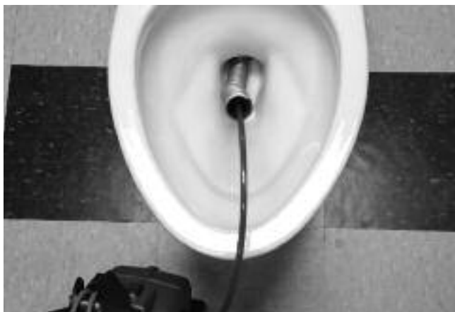
Рис. 25. Использование гибкой направляющей трубы
