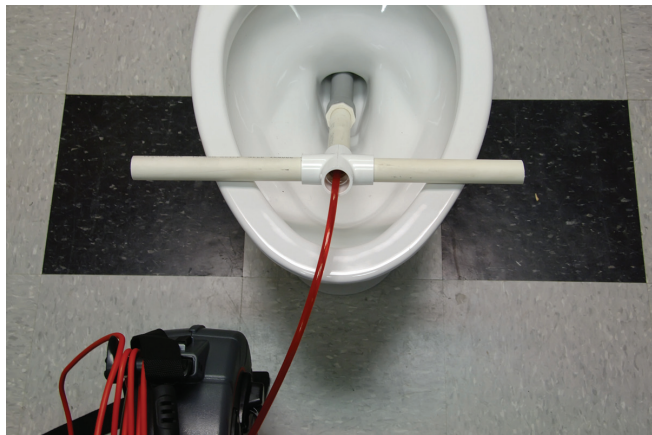
Рисунок 22 – Использование ПВХ направляющей трубки
