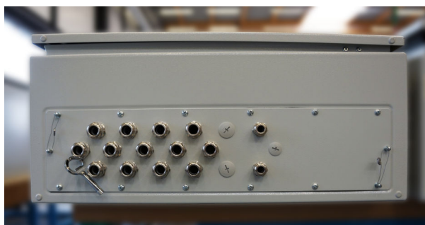
26 Расположение кабельных вводов
