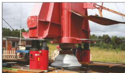
Подъем вышки связи и ее удержание на время замены изолятора
